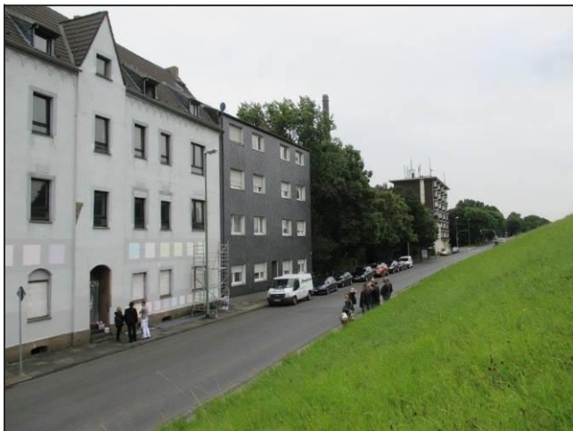
Abbildung 20: Aufbringung des Farbkonzeptes (Immobilie Deichstraße 32) 19
